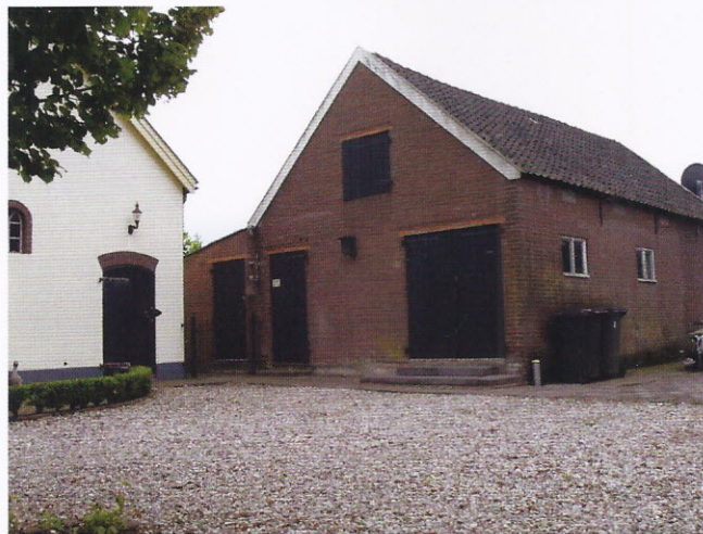
Deel van de huidige achtergevel en de schuur van 'het Grote Laar'. Onder de schuur bevindt zich de waarschijnlijk laatmiddeleeuwse kelder, die oorspronkelijk onder het huis zat.
