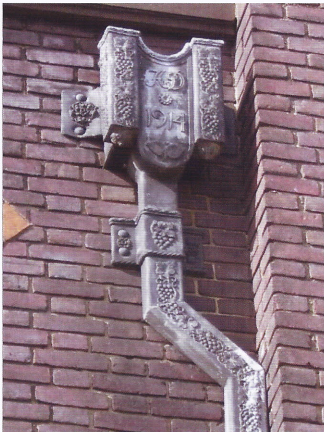
Regenpijp met opvangbak
