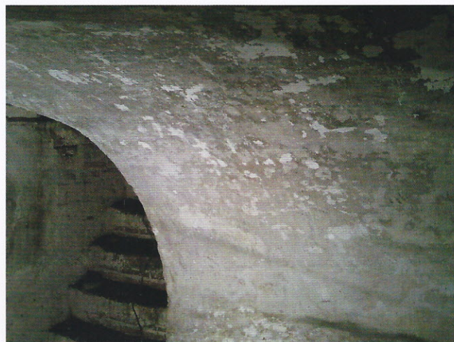
Het tongewelf van de kelder onder de schuur. Op de achtergrond is nog een deel van de trap te zien. (foto W.F.J. van Dijke)
