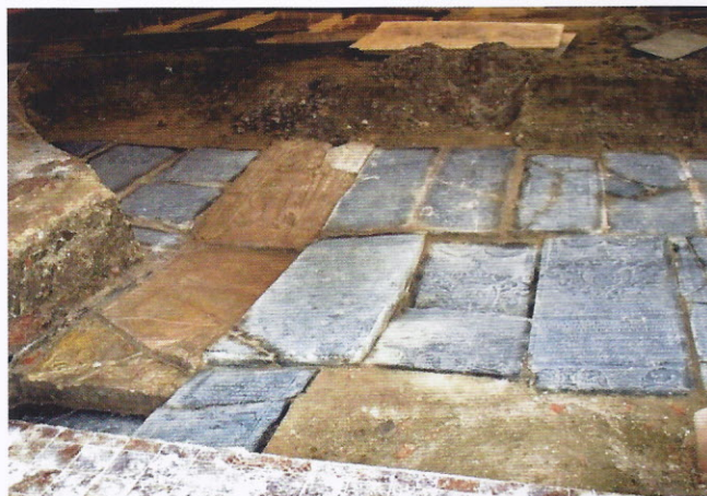
Kerkvloer in restauratie
