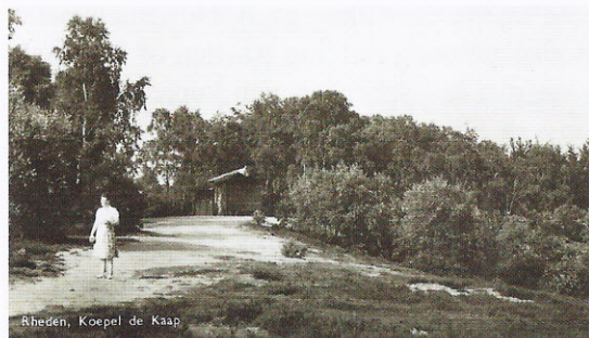
Koepel de Kaap met ingezakt dak 24-07-1950
